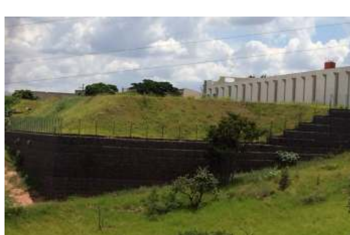
MUROS E GABIÃO
