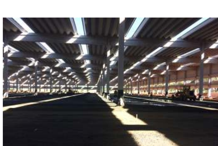
PISO DE CONCRETO
